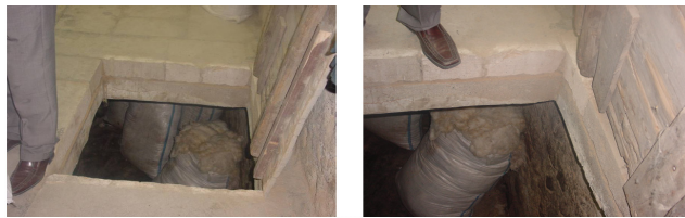
Şekil 16. 1968-1973 yılları arası yıkılan ahşap döşemenin yerine yapılan taş döşeme.
