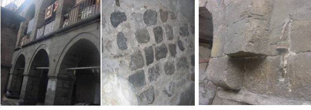
Şekil 5. Birinci Avlu- Düzgün kesme taş ile yapılmış kemerler – Odalardaki moloz taş duvar örüntüsü- Gergi kılıcı
