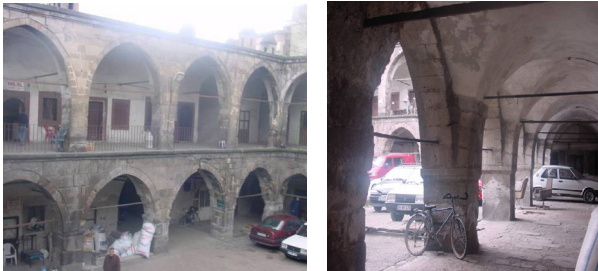
Şekil 6. Paye ve kemerlerden oluşan taşıyıcı sistem ve orta avludaki geniş revalar
