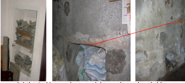
Şekil 14. Yaşama birimindeki eşyalarını koydukları niş-aşşap hatıl
