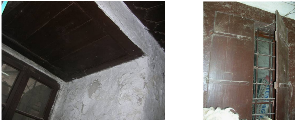
Şekil 17. Odalarda kullanılan 'ahşap zar' ve ahşap kepenkler
