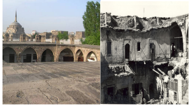
Şekil 8. 1968- 1973 yılları arası onarım projesi sonucu taşla kaplanan çatı- Onarımdan önceki durum 1968.
